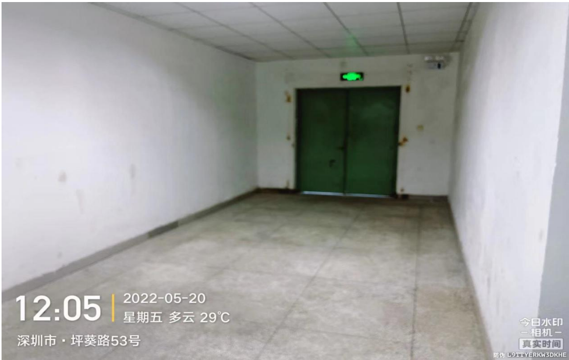
葵冲邮政综合楼
