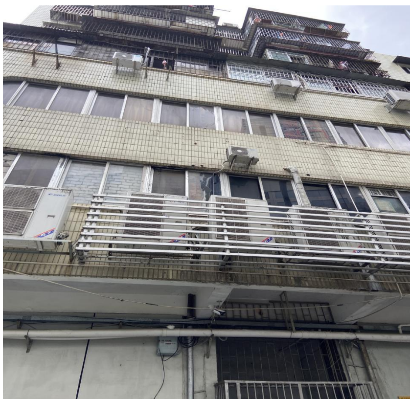
19、邮政大厦北侧建东楼101房
